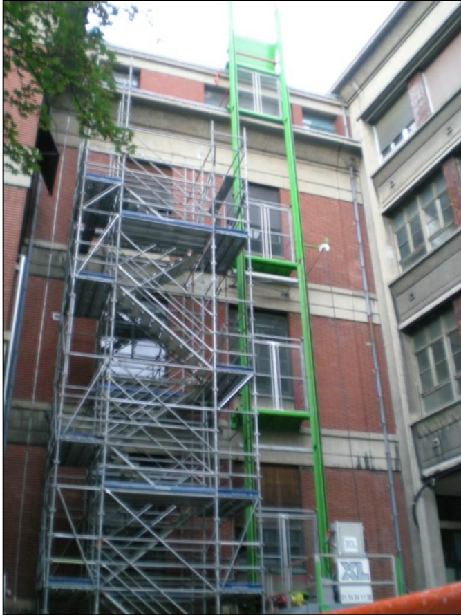
Installation du lift chantier jardin
