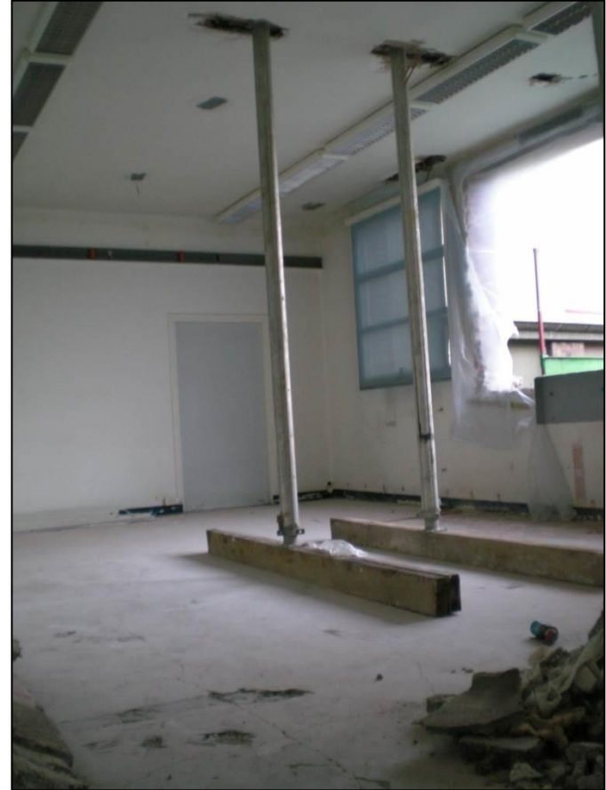
Installation du lift chantier 3 e étage Lhomond
